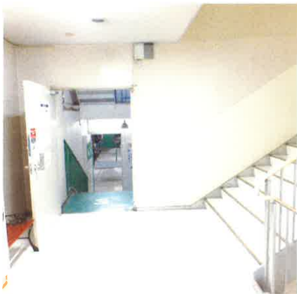
駐車場に向かう通路 です。各階駐車場へ 行けます。
