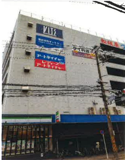
ファミリーマート側、駐車場棟です。
